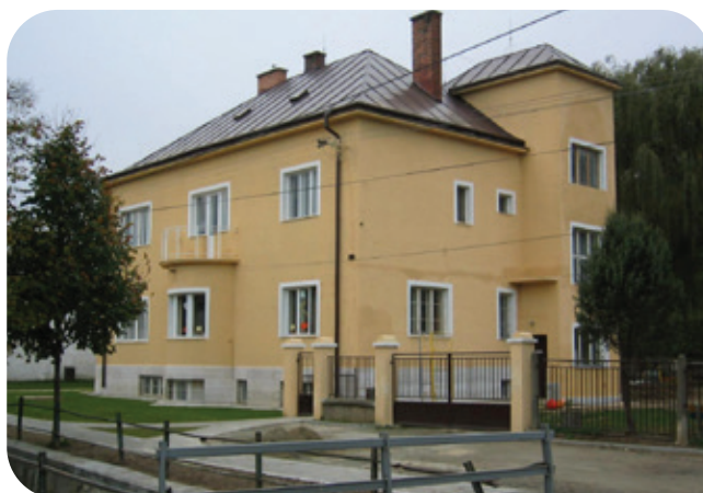
● Pohľad na budovu bývalého notariátu pred rekonštrukciou.
