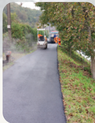
● Rekonštrukcia Sokolskej ulice.
