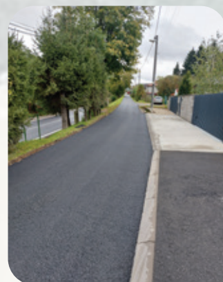
● Sokolská cesta s novým asphaltovým kufrom.
