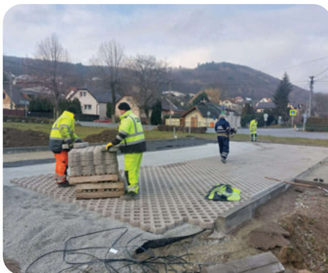
● Výstavba parkoviska v centre obce.
