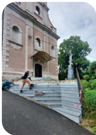
● Rekonštrukcia schodov farského kostola.
