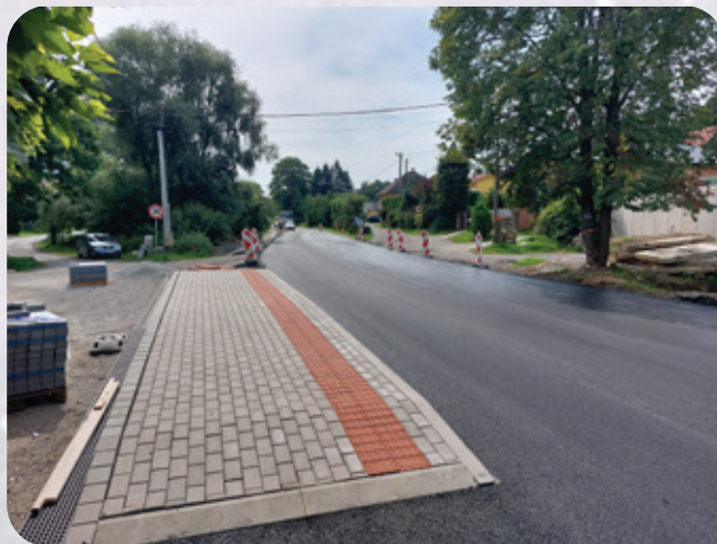
● Rekonštrukcia cesty Kostolaný – Sokol'.
