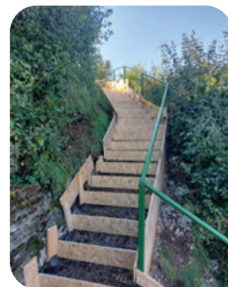
● Rekonštrukcia schodov na ul. Svornosti.
