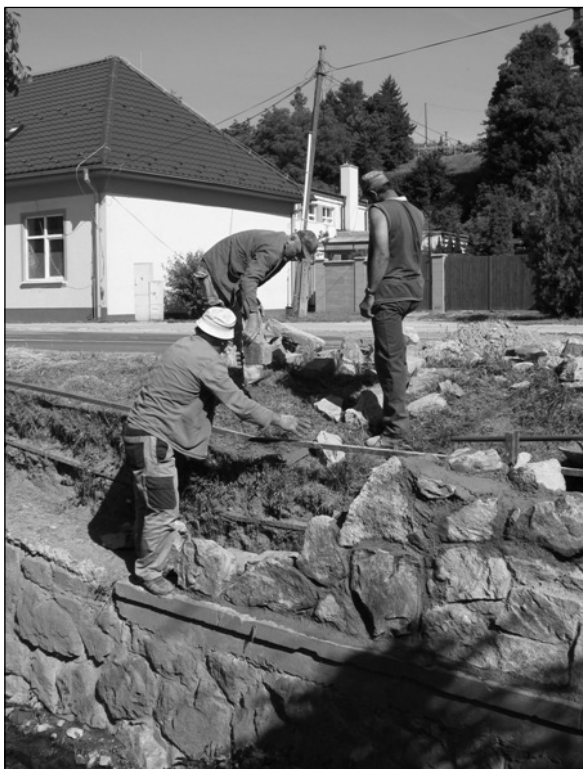
Práce na vyvýšení regulácie potoka a úprave priestranstva na Košickej ulici
