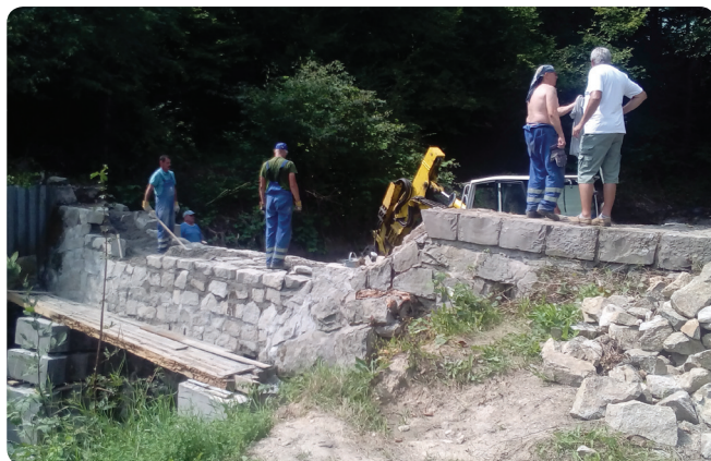
Rekonštrukcia hate na potoku Hrubeč
